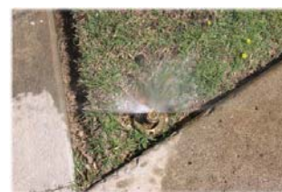
Los aspersores rotos o mal ajustados (como se aprecia arriba) desperdician miles de galones de agua al año. Ajustando los aspersores de los sistemas de irrigación puede ayudar a ahorrar hasta 25 galones de agua al día.
