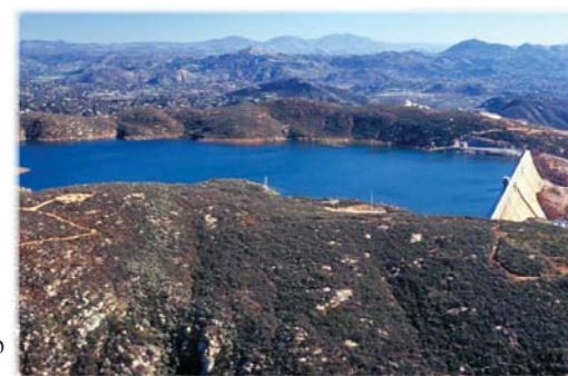
La Presa de Almacenamiento Olivenhain, finalizada en el 2003, es la primera presa de esta magnitud que ha sido construida en la región de San Diego en 50 años. La presa tiene la capacidad de almacenar 24,000 acres-pies de agua.
