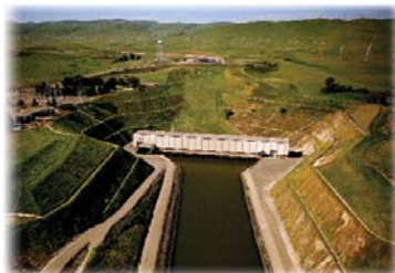
En el 2008, el bombeo de agua de la planta Harvey O.Banks podría llegar a ser restringido por hasta un 30 por ciento.
